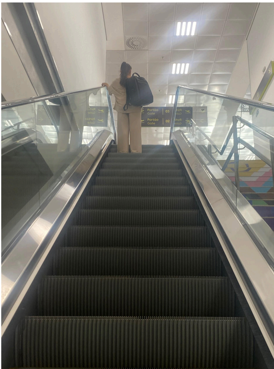
Imagem 1: Escadas rolantes para a área de embarque no Aeroporto Internamente de Porto Velho. Data: 13/09/2025.
