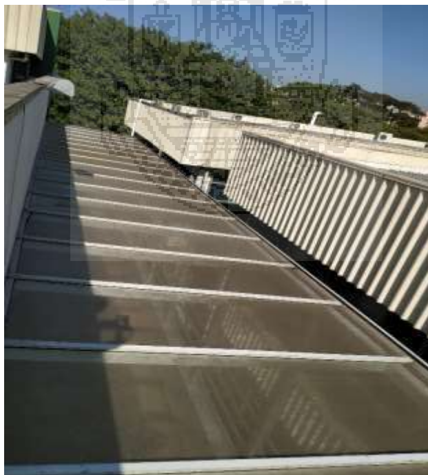
FOTO 05 - Vista Cobertura de vidro (acesso BMA ANEXO) ICB III
