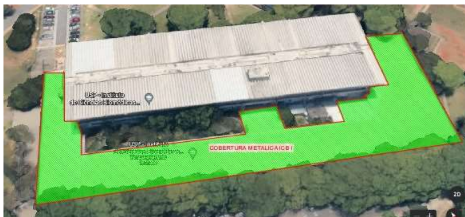
Foto 01 – COBERTURA METALICA ED. ICB I
