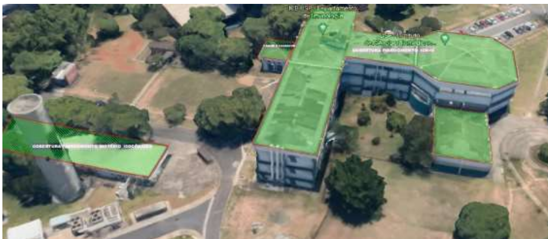
Foto 06: COBERTURA ICB IV / Abrigo Gerados / Biotério Isogênicos
