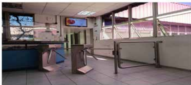
Foto 2 – instalação de novas catracas de acesso aos edifícios
