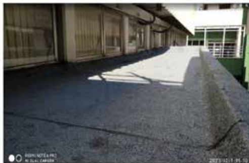
Foto 4 – Impermeabilização de lajes e coberturas ( ICB III)
