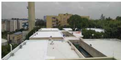
Foto 5 – Manutenção de calhas e rufos (ICB III)
