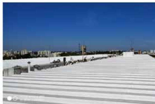
Foto 7 – Impermeabilização de cobertura (ICB I)
