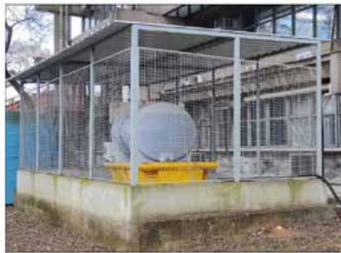
Foto3 – Instalação do tanque de óleo diesel do gerador do ICB I em área externa ao prédio
