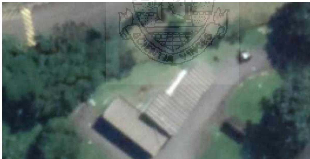
Foto aérea com baixa definição, local a disposição para vistoria.
